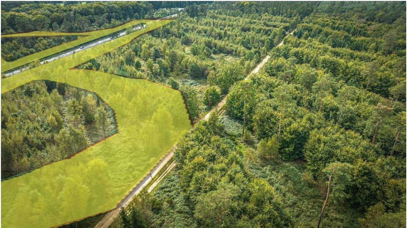
Figuur 7: Door aanleg van extra afslag onder het asfalt verdwijnend bos (Foto en bewerking: Groen Grensland)
