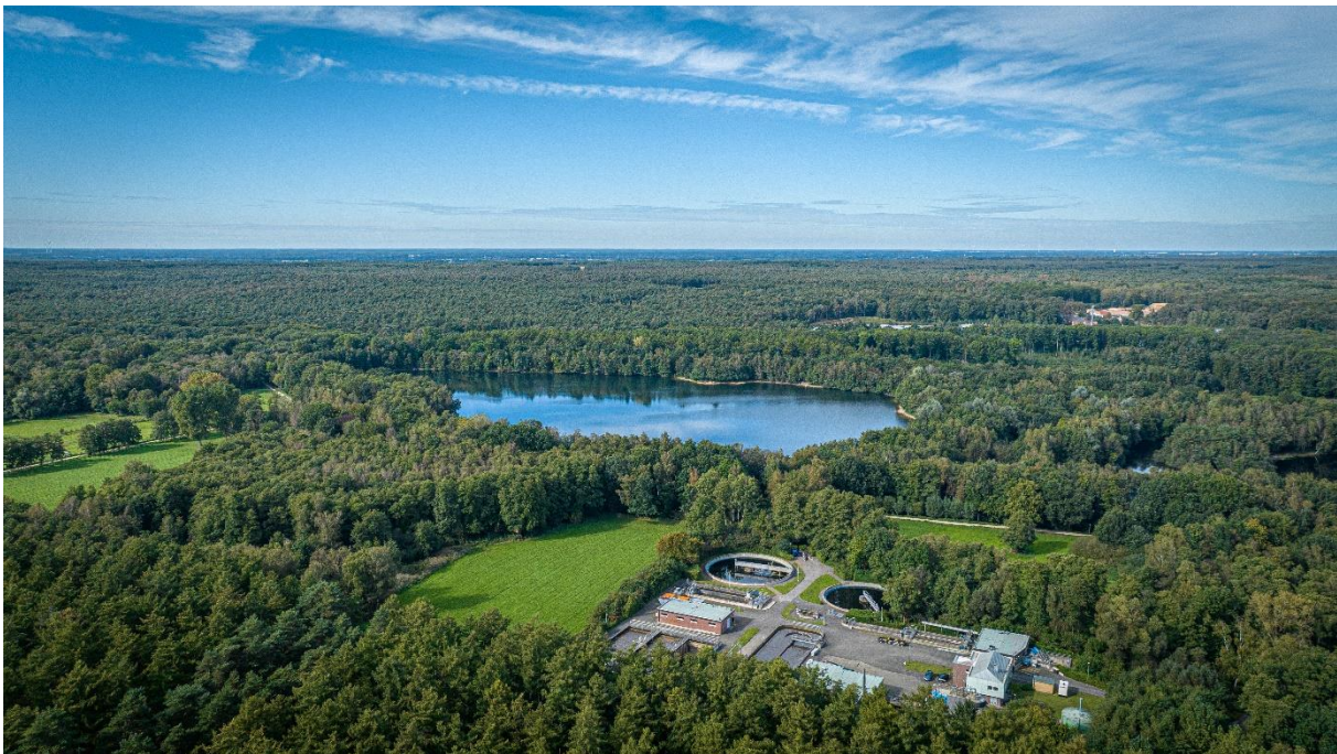
Figuur 1 Luchtopname van zuiveringsinstallatie Overhetfeld in het Swalmdal met op de achtergrond de Damen See
