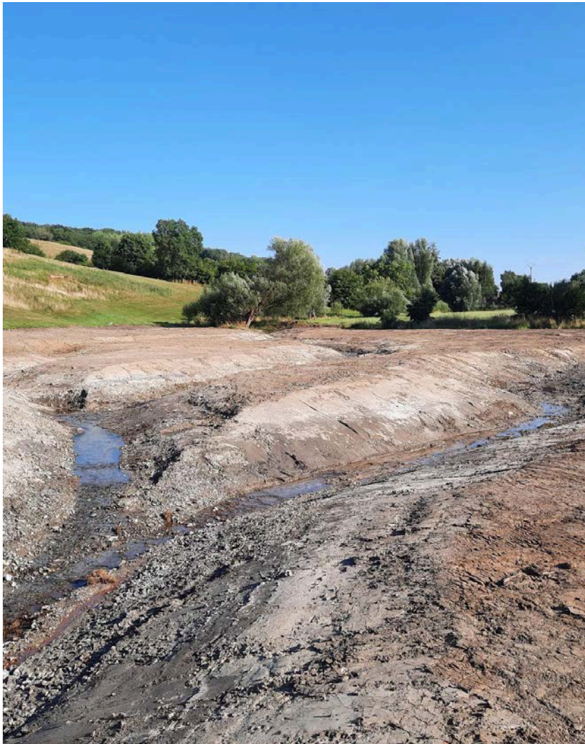
Voorbeeld van beekherstel in het bovenstroomse deel van de Gulp, waarbij de beek weer de gehele breedte van de dalvlakte kan innemen.
